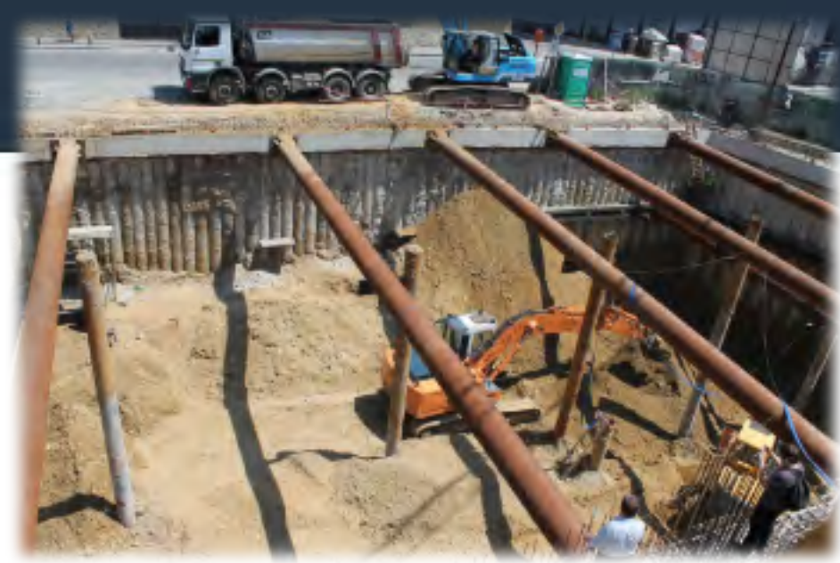
Secant Pile Wall
