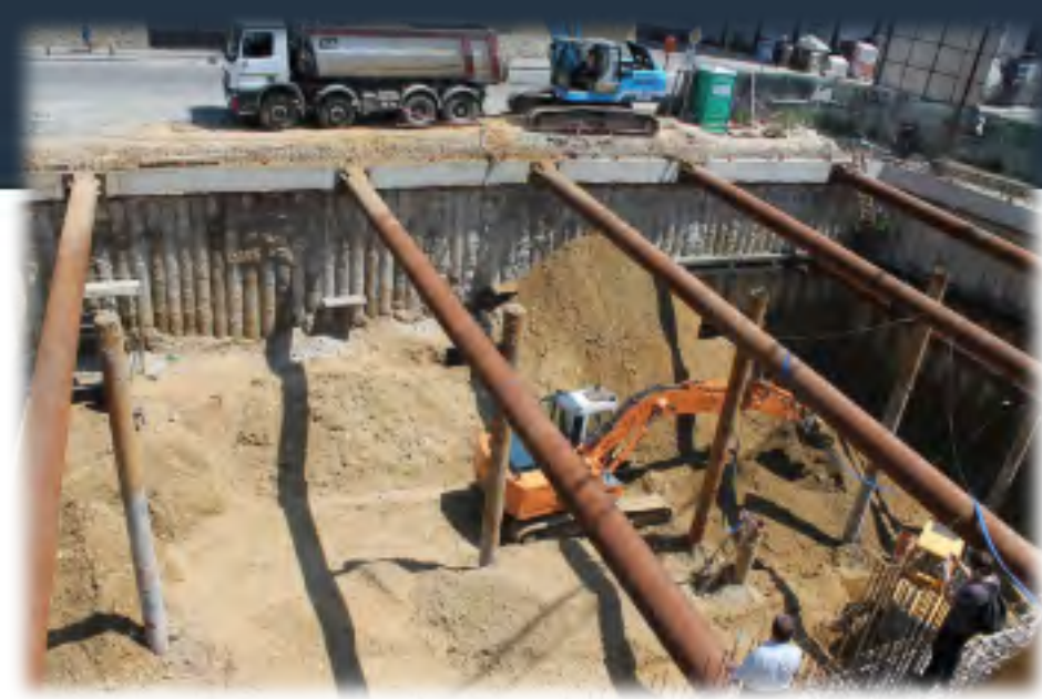
Secant Pile Wall
